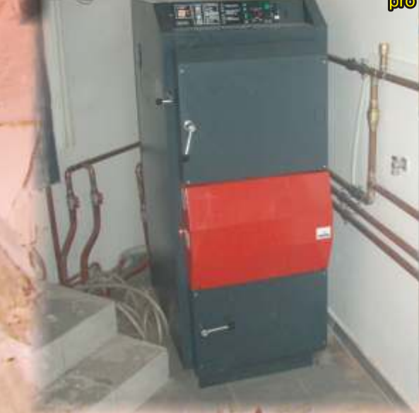
Kotel VERNER VN 45 v kombinaci s akumulací nádrží REGULUS a slunečními kolektory KPS 11 ALP pro přitápění
