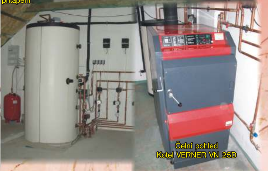
Kotel VERNER VN 45 v kombinaci s akumulací nádrží REGULUS a slunečními kolektory KPS 11 ALP pro přitápění
